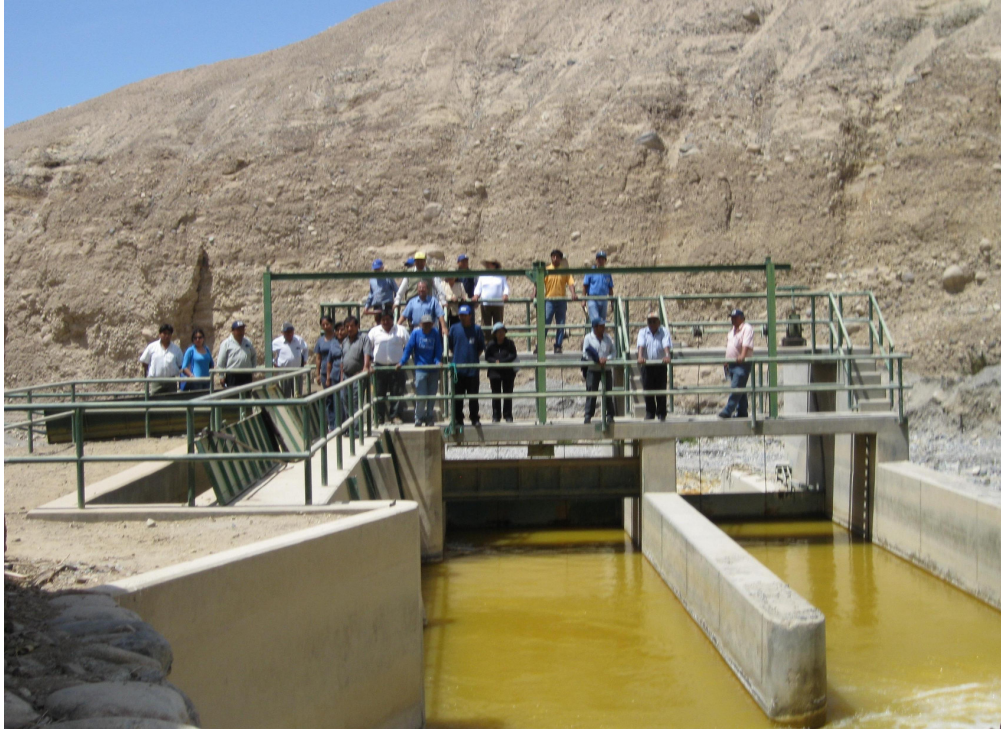
Visita realizada a la Bocatoma Challata – Tacna
