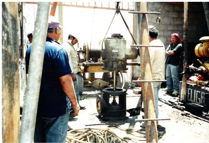
DESMONTAJE DE MOTOR VERTICAL DE EJE HUECO Y LINTERNA DE BOMBA TURBINA VERTICAL.
