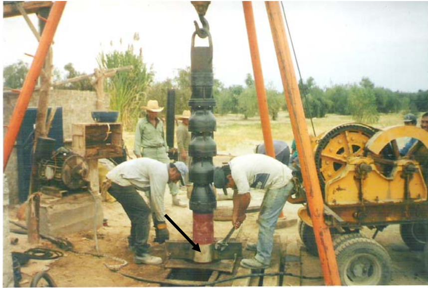
FOTO N° 20 MONTAJE DE CUERPO DE BOMBA TURBINA VERTICAL O DE EJE, DE 3 ETAPAS, OBSÉRVESE ABRAZADERA DE SOPORTE (FLECHA)
