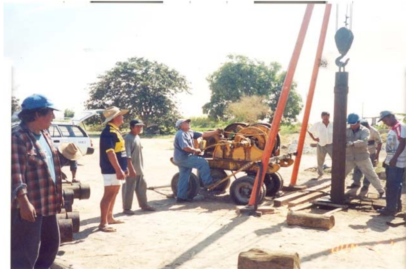
DESMONTAJE DE TUBERÍAS DE DESCARGA FOTO N° 27
