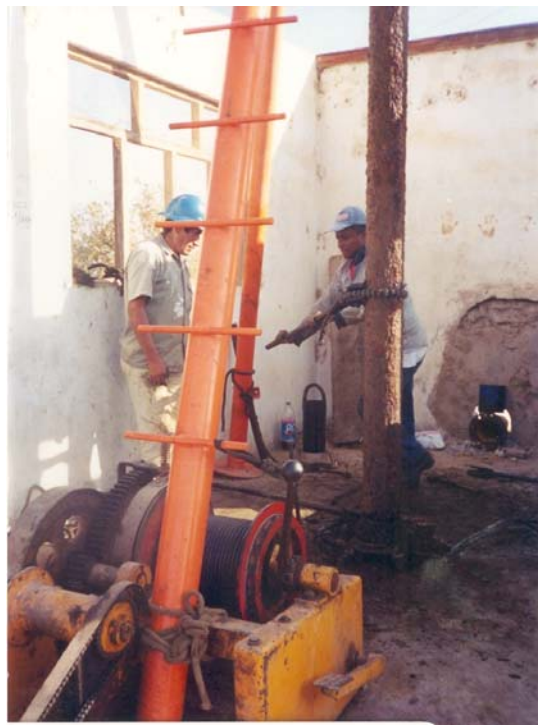
DESMONTAJE DE TUBO DE DESCARGA FOTO N° 28
