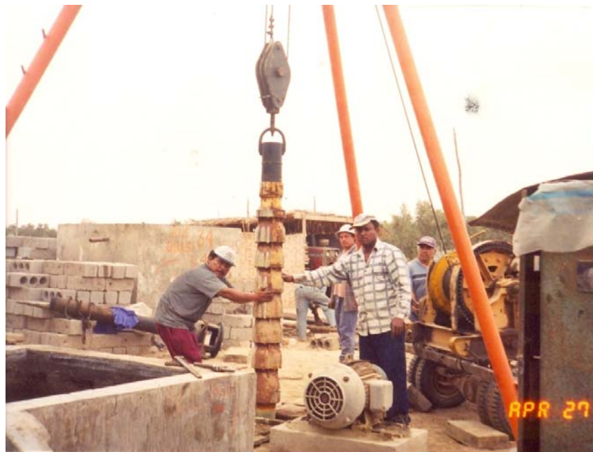
OBSÉRVESE EL DESMONTAJE DEL CUERPO DE BOMBA TURBINA VERTICAL Ó DE EJE, DE 6 ETAPAS. FOTO N° 29
