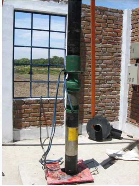
INICIO DEL MONTAJE DE BOMBA SUMERGIBLE FOTO N° 5
