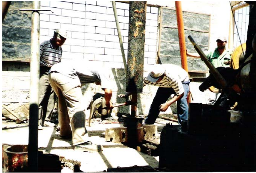
DESMONTAJE DE TUBERÍAS DE DESCARGA, FUNDAS Y EJES FOTO N° 26
