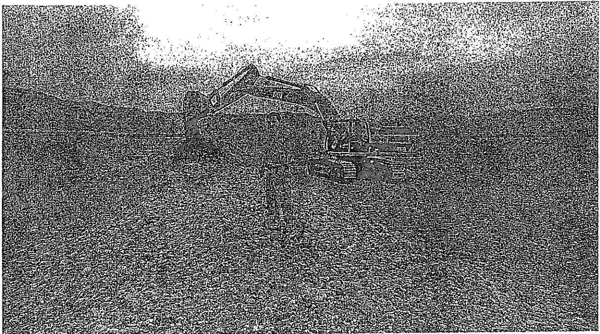
MAQUINARIA CONFORMANDO DIQUE CON MATERIAL GRANULAR
