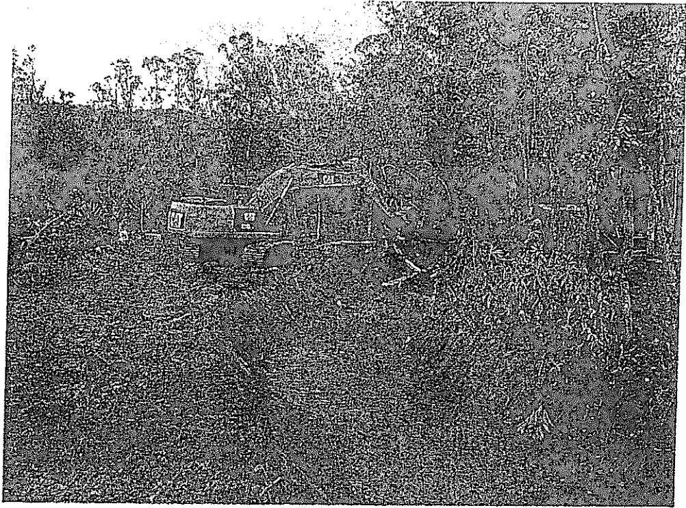
DESCOLMATACION DEL CAUCE QUEBRADA CON MAQUINARIA KM 0+594
