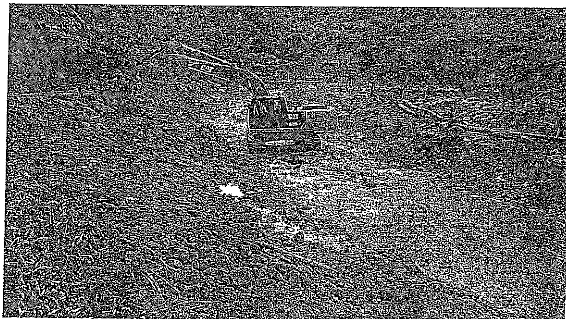
TRABAJOS LIMPIEZA Y DESCOLMATACION DEL CAUCE
