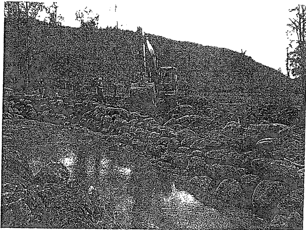
COLOCACION Y ACOMODO DE ROCA EN TALUD KM 0+414-KM 0+455
