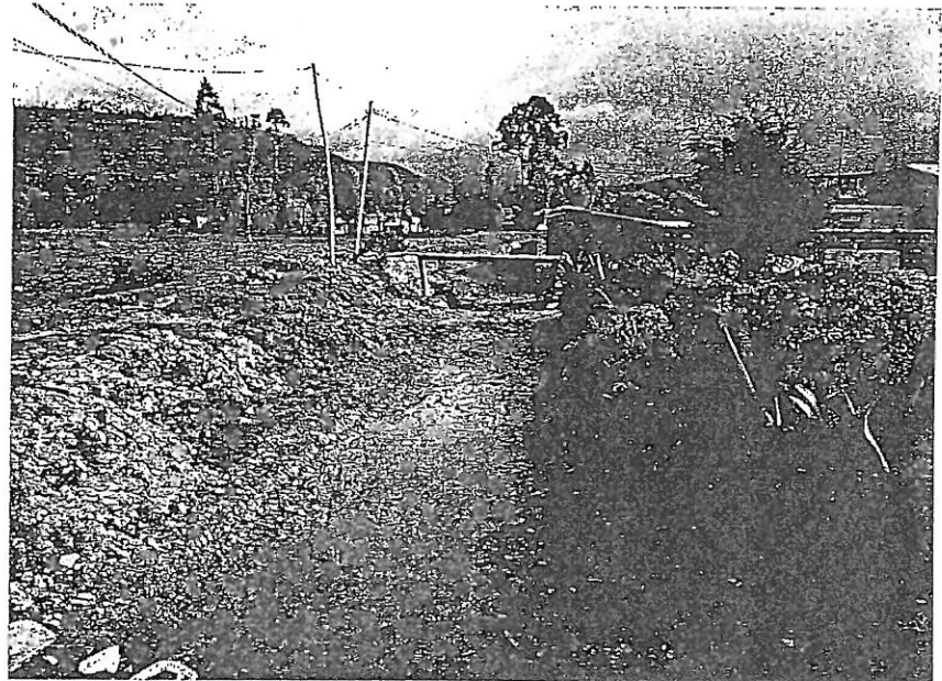
Vista de la limpieza y descolmatación de la quebrada Chacarrume-Celendín.- Dic. 2015
