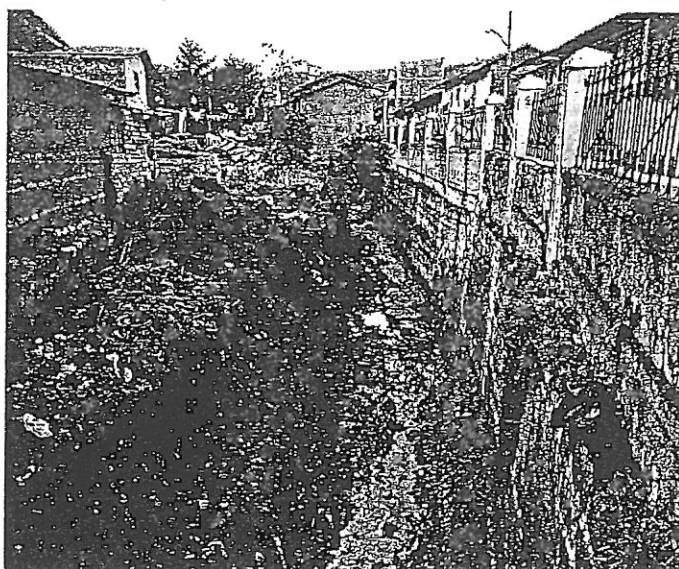
Vista de la limpieza y descolmatación de la Qda. Intihuana, que desemboca al río Chico. Dic. 2015
