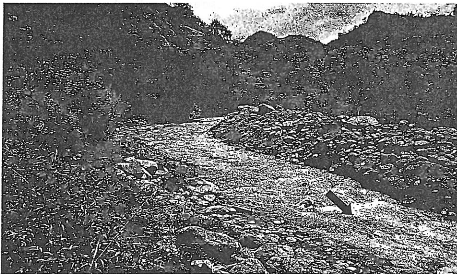
Vista de la población de Chacanto, expuesta a inundaciones y que se aminora el peligro con la descolmatación del río Hawuay. Tramo hacia aguas arriba descolmatado. Dic. 2015
