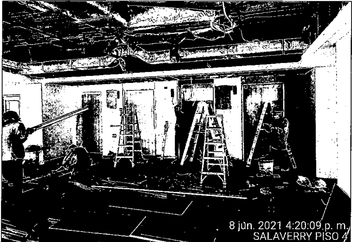
Vista de trabajos de cerramiento con drywall de vestíbulo de elevadores en Torre Salaverry.
