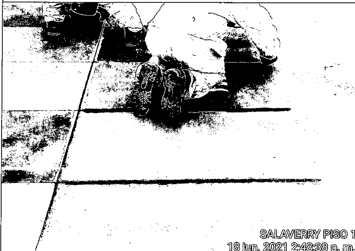
Vista de trabajos de fraguado de juntas en porcelanato de 0.90x1.20 explanada Salaverry.
