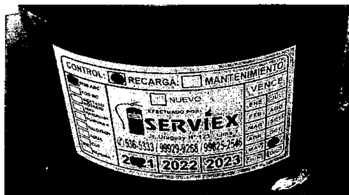
Imagen N°04. Inspección de equipos de extintor de obra
