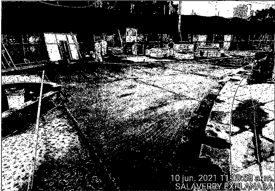
Vista de vaciado de contrapiso de piso estampado en Explanada.
