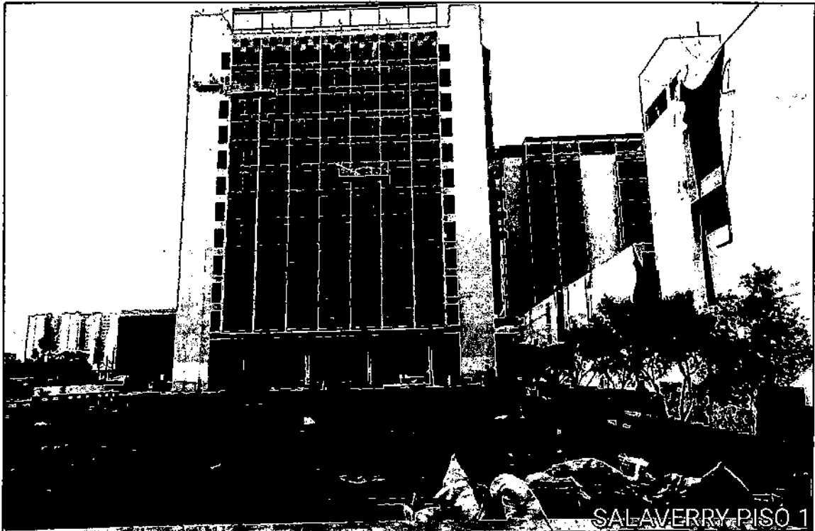
Vista de trabajos de explanada, y fachada ventilada en torres Cahuide y Salaverry.
