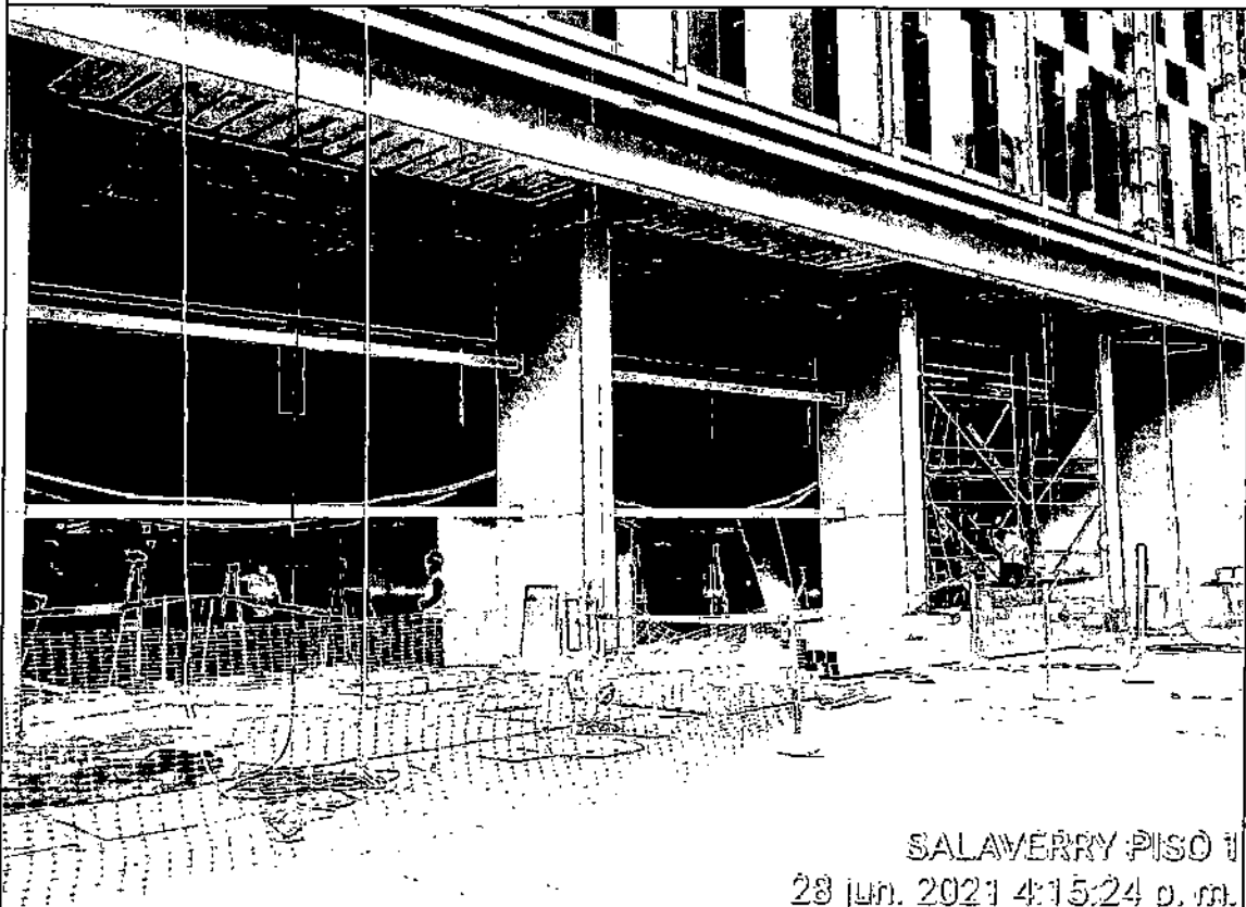
Vista de trabajos de instalación de estructura metálica de sistema Spider en vestíbulo principal de torre Salaverry.
