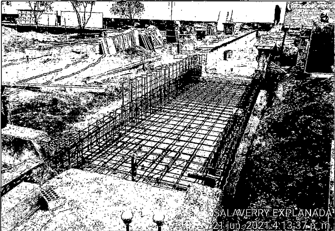
Vista de estructura de acero para ultimo paño en espejos de agua en Explanada.
