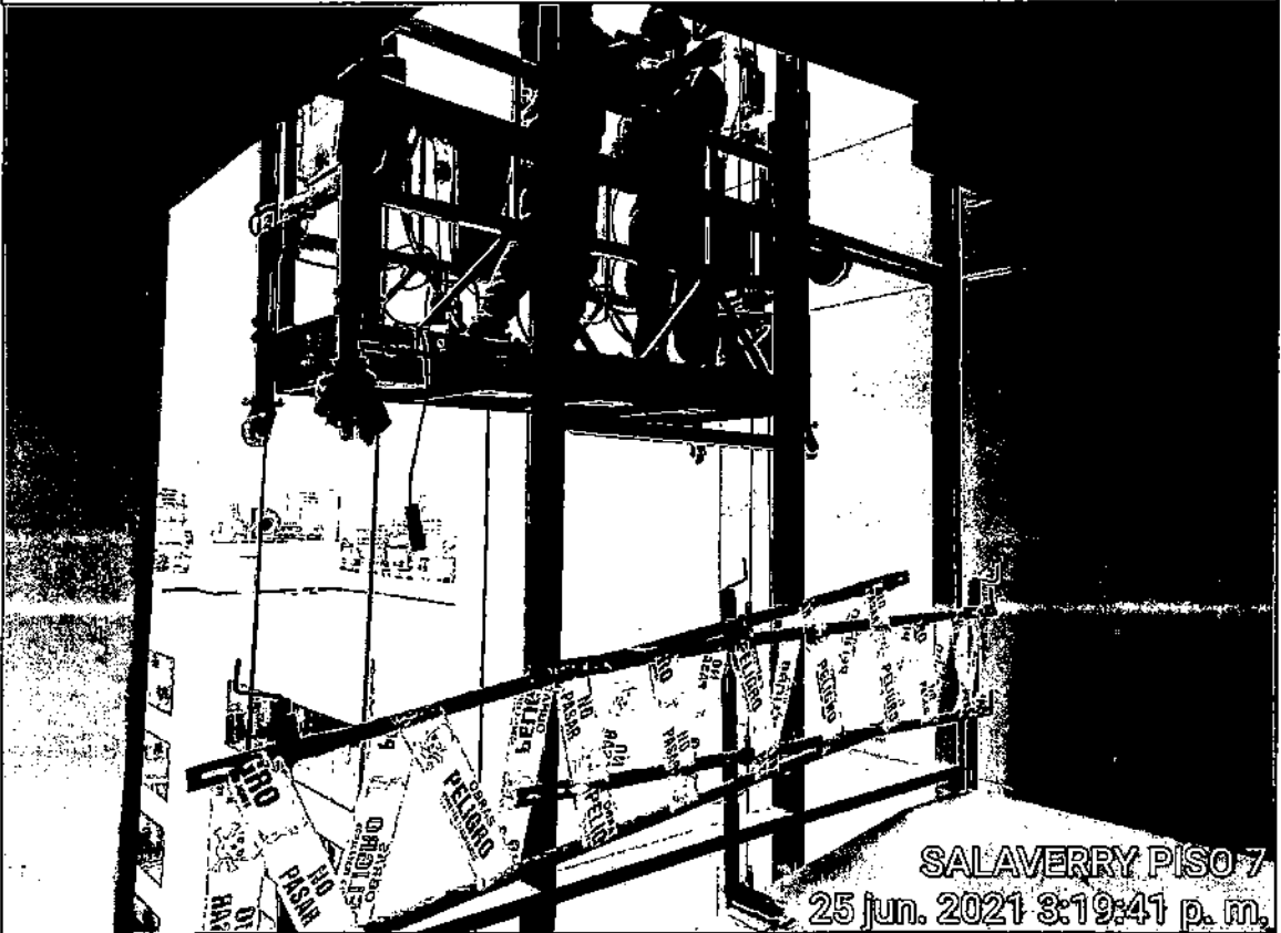
Vista de trabajos de instalación de muro cortina en puente de conexión entre Torre Salaverry y Cahuide.
