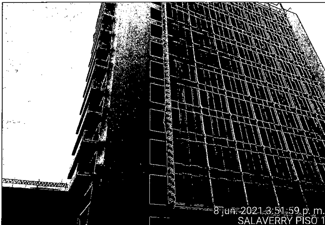
Vista de colocación de aluminio compuesto para mascarón en torre Salaverry.
