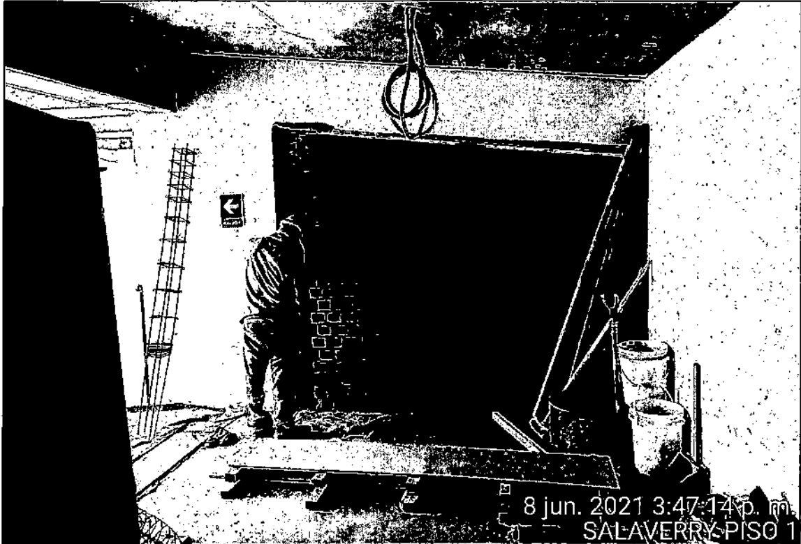
Vista de colocación de unidades de albañilería y encofrado de columnas de amarre en muros de Torre Salaverry.
