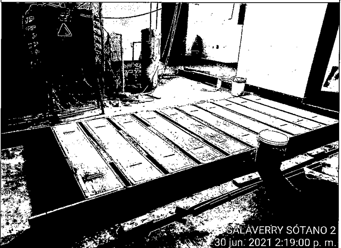
Vista de trabajos de encofrado de tapas desmontable en ducto técnico de torre Salaverry.
