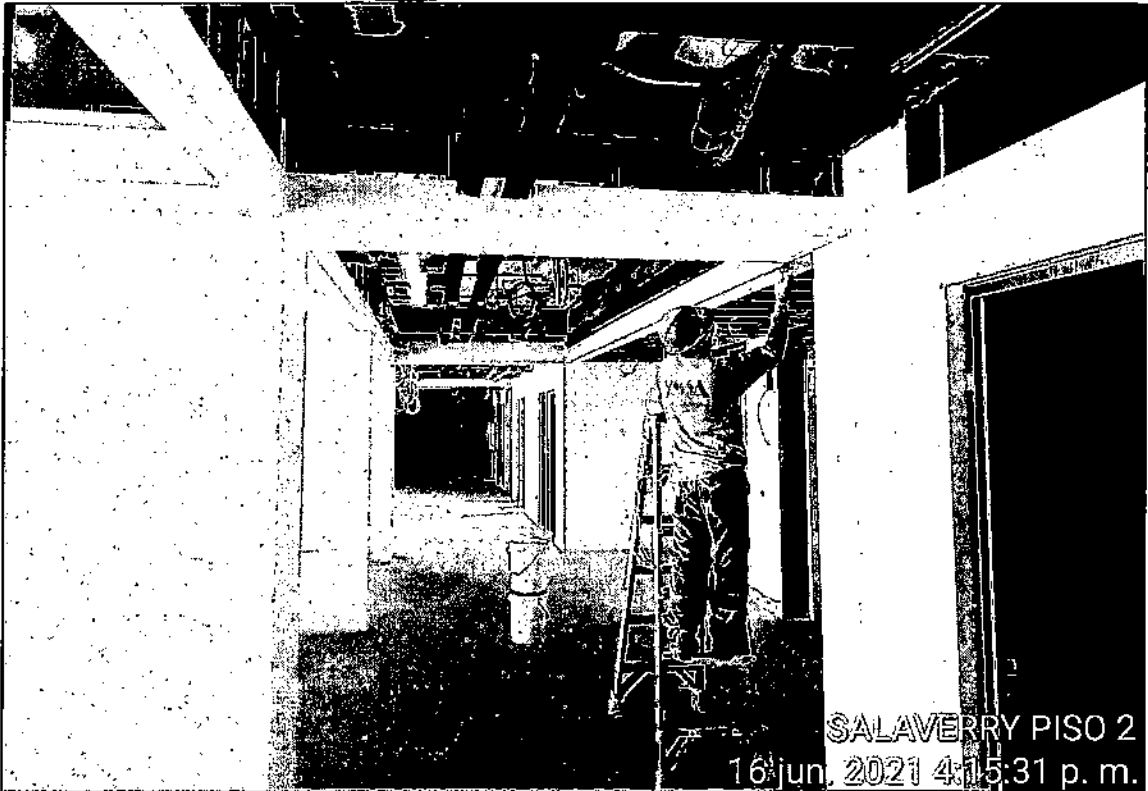
Vista de trabajos de empaste en falso cielo raso en Torre Salaverry.
