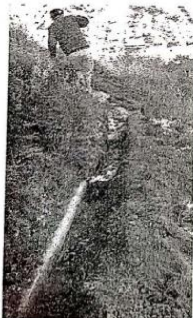
Figuras 01 y 02: Tubería PVC SAL de 6" de la línea de distribución del sistema de Riego Q'euñalla deteriorada y se evidencia roturas en la tubería.
