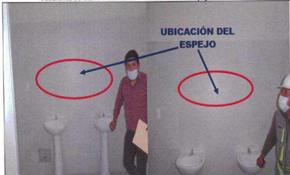
PANEL FOTOGRÁFICO N° 1 Ambiente de SS.HH. Hombres – Instalación de Espejos
