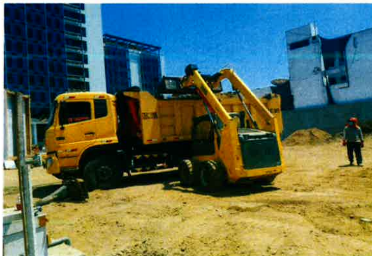
Imagen N°13. Limpieza de escombros y materiales sobrantes
