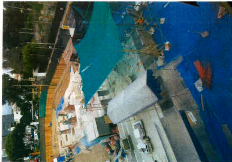
Imagen N°07. Uso de barandas de seguridad.
