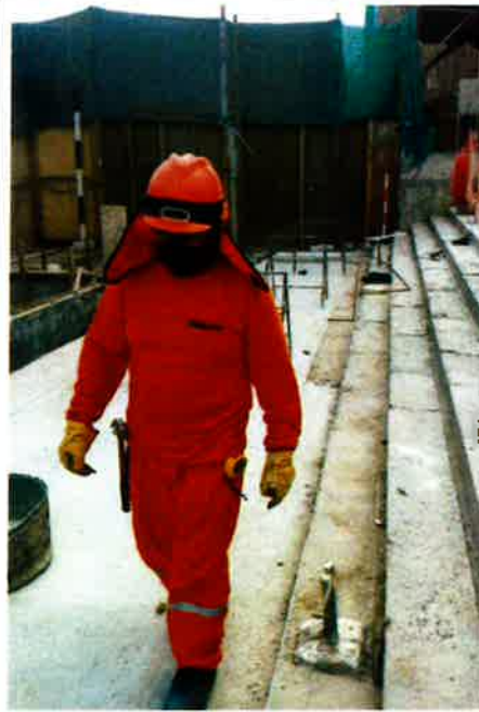
Imagen N°05. Personal de obra usando epps correspondientes.
