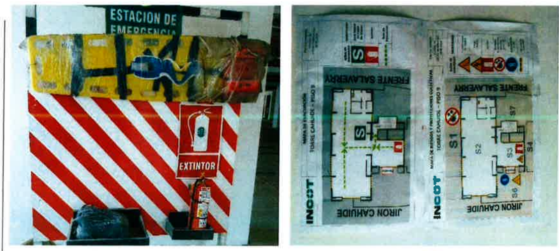
Imagen N°016. INSTALACION DE ESTACION DE EMERGENCIA Y MAPA DE RIESGO
