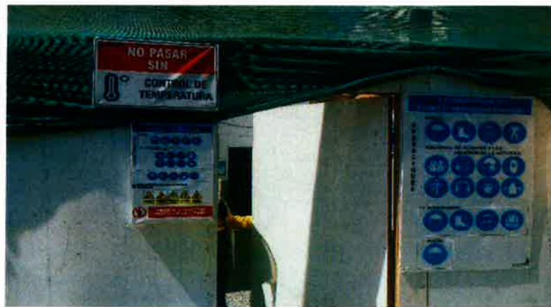
Imagen N° 8. Señalética de uso obligatorio en el nuevo punto de ingreso a obra.
